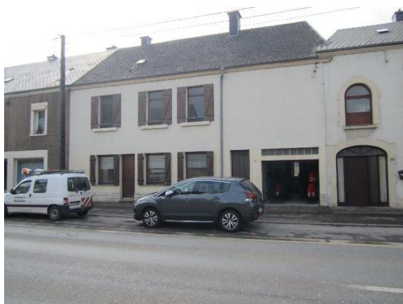
Vue sur le bâtiment (façade avant)
