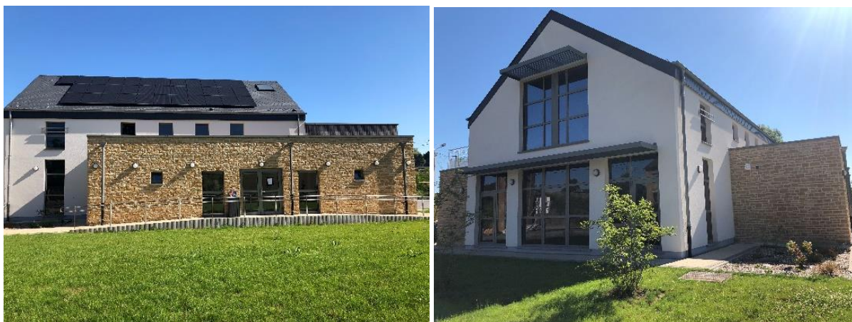
Maison de village après travaux
